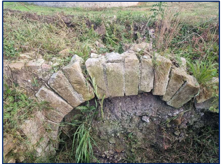
Foto 2: Ronde boog van de overkluizing binnen / buitengracht voor de restauratie.
